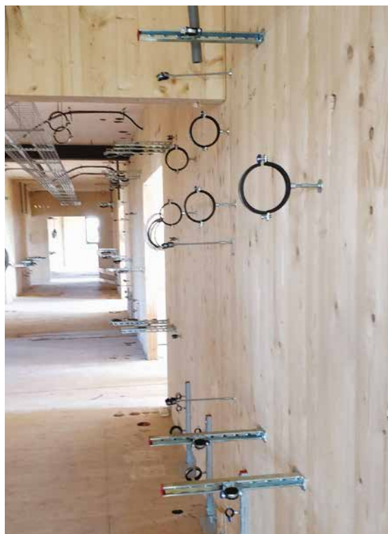
Figure 2 : Mise en place des équipements techniques dans le chantier de l'hôtel Bercail à Wambrechies. © Stabilame - Agence Kevin Velghe Architecte, Paris.
