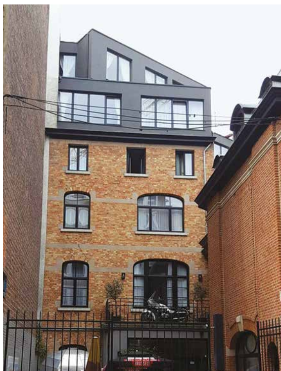
Figure 5 : Hôtel Vintage, avenue Louise, Bruxelles. Ajout de 3 niveaux supplémentaires en ossature bois réalisé en 3 mois. © Architecte : AS BUILT architects – Entreprise : TS Construct
