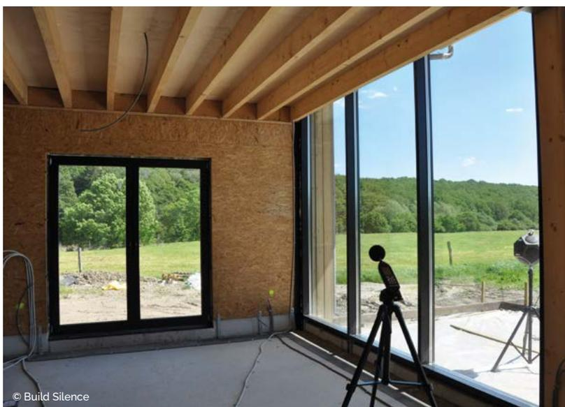
Photo 2 : Mesure indicative de l'isolement acoustique des façades par rapport aux bruits extérieurs.
