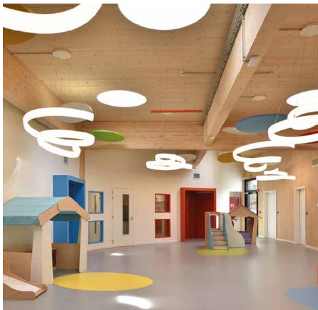
LE SYSTÈME CONSTRUCTIF CLT, POTEAUX-POUTRES
