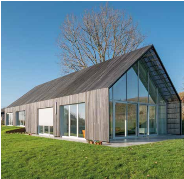
LE SYSTÈME CONSTRUCTIF OSSATURE BOIS
