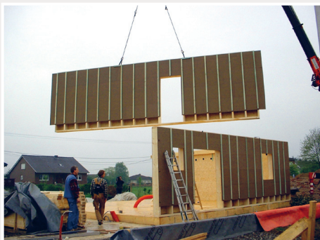
Pose d'une ossature bois
