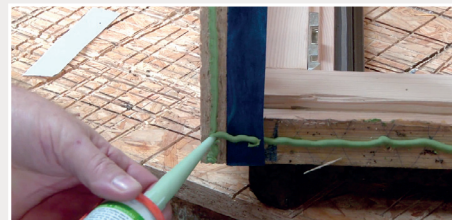
Pose du film de joint étanche sur le bâti de la menuiserie et sur le chant des montants du pré-cadre, pour effectuer le raccord entre les traverses et les montants du pré-cadre – cordon continu au-dessus et en dessous de l'adhésif
