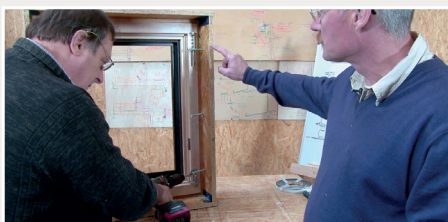
Positionnement des vis – minimum diamètre 6mm (DTU 36.5)
