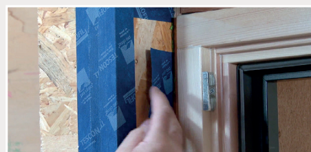
Pose des adhésifs sur les vis de fixation du précadre sur la structure
