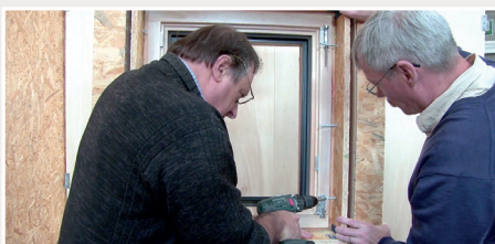
Vissage du précadre avec sa menuiserie dans la structure
