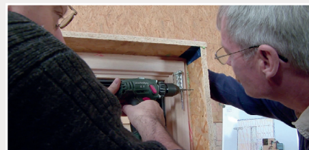
Pré-perçage des précadres avant insertion dans la structure – un à chaque niveau des organes de rotation de la menuiserie
