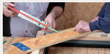
Pose du film de joint étanche, ininterrompu et de largeur minimale de 5mm, sur les montants du pré-cadre
