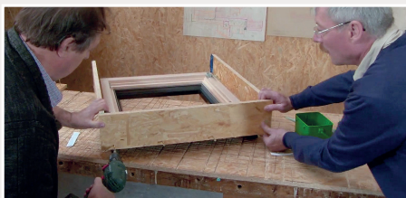
Positionnement des traverses du pré-cadre
