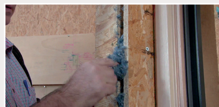
Pose de l'isolant en vrac derrière le précadre
