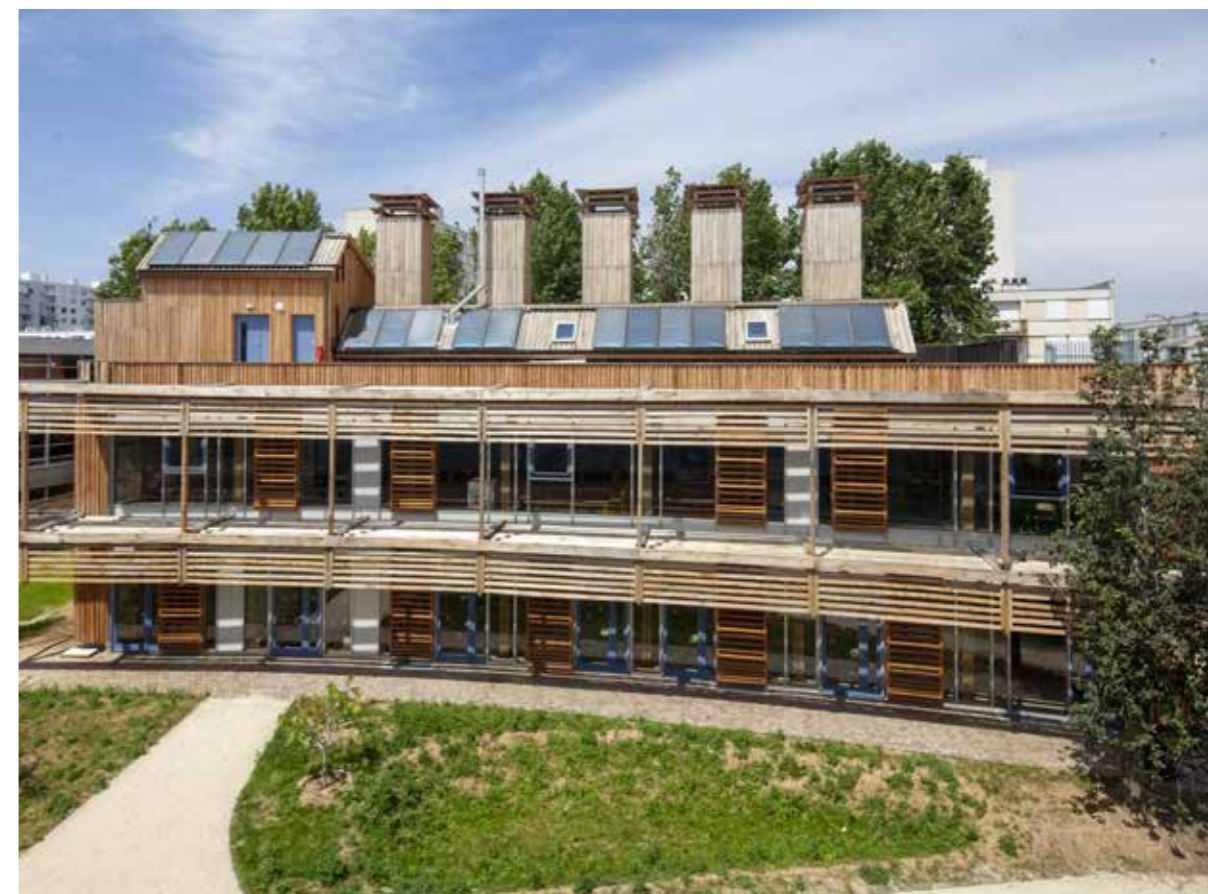
Figure 4: Centre de loisirs Jacques Chirac à Rosny-sous-Bois (France - 93). Bâtiment R+1 recevant du public en paille porteuse (Source : Mairie de Rosny-sous-Bois, © Juan Sépulveda)
