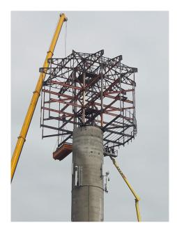
La seconde étape a porté sur le démontage de l'escalier unique qui partait du socle en béton vers le sommet de la tour et ne répondait plus aux impératifs ergonomiques et de sécurité actuels. Décision a donc été prise de le remplacer par un double escalier hélicoïdal en béton. L'implémentation de ce nouvel escalier
