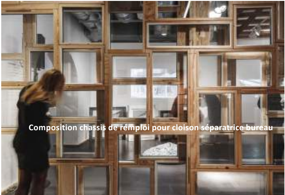
Doublage châssis de réemploi et remplissage avec matériaux du site – montrer la démarche circulaire dans l'architecture
