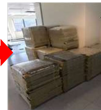
Bâtiment de bureaux de l'ONSS : suppression des murs intérieurs → Résultat : 10 000 m 2 d'isolation de toiture
