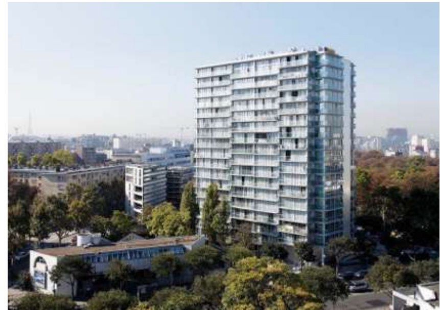
Tour Bois-le-Prêtre, Lacaton et Vassal
