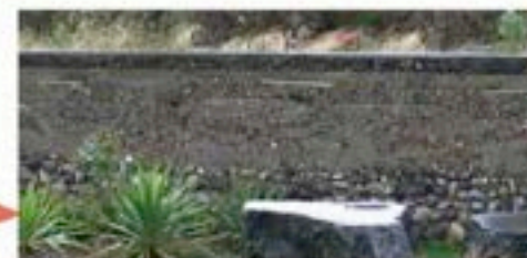
MUR FAÇON PISE
