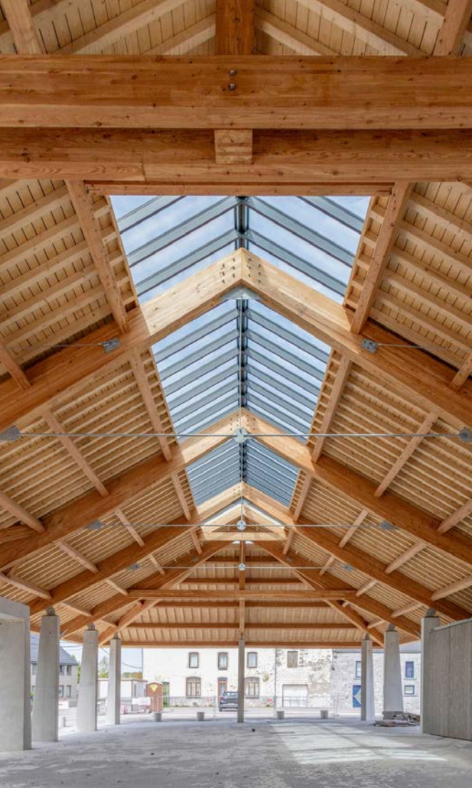
Au cœur du village d'Onhaye, la halle couverte est prête à accueillir marchés et autres événements. (Photo : Entreprise Pierre Collignon - Chimsco)
