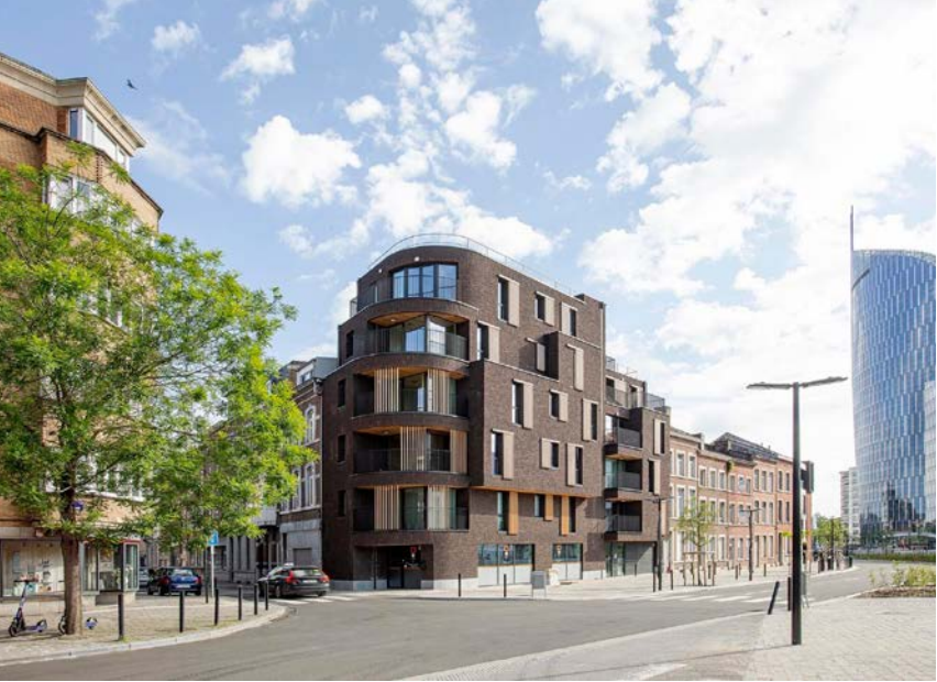
Dans le quartier des Guillemins à Liège, on ne devine pas que la Résidence Paradis a été entièrement construite en bois. Et pourtant... (Photos : La Maison de Demain)
