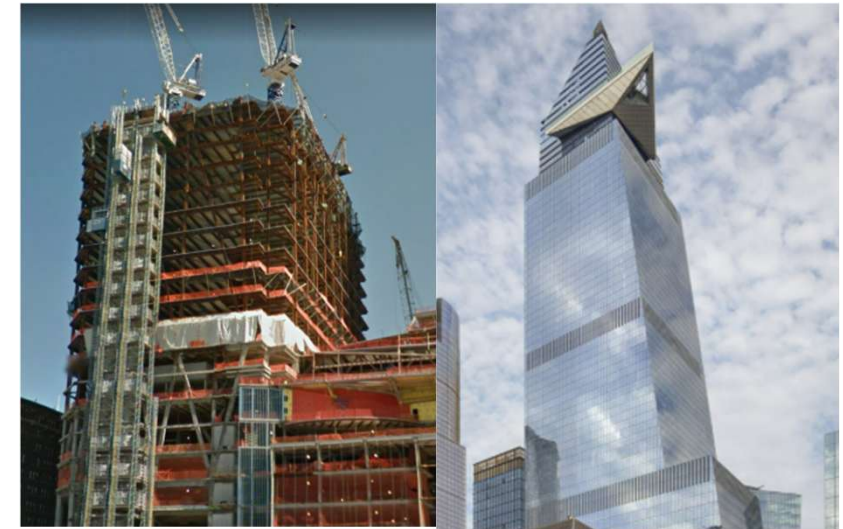
30 Hudson Yards – 2014 à 2019 5 ans de travaux – 395m
