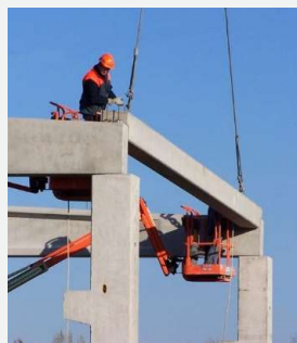
Structure béton préfabriqué
