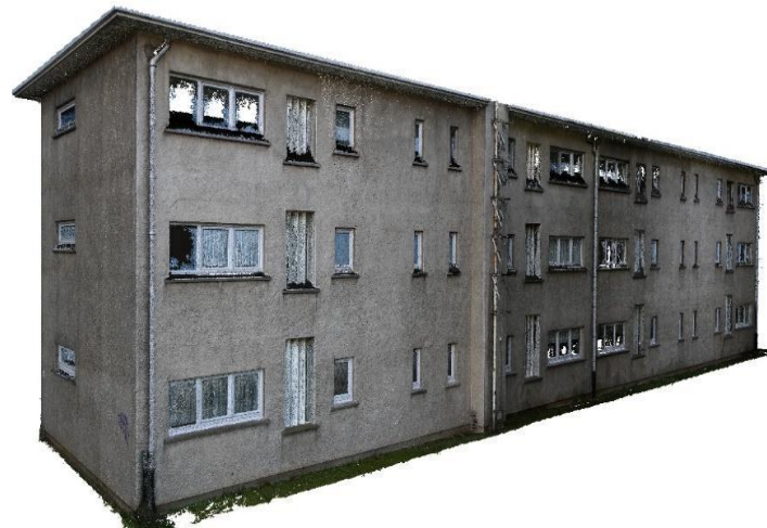
R+2 12 logements existants et habités
