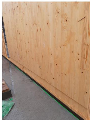
Défoncement pour plinthe intégrée
