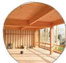
Poteau-poutre CLT
